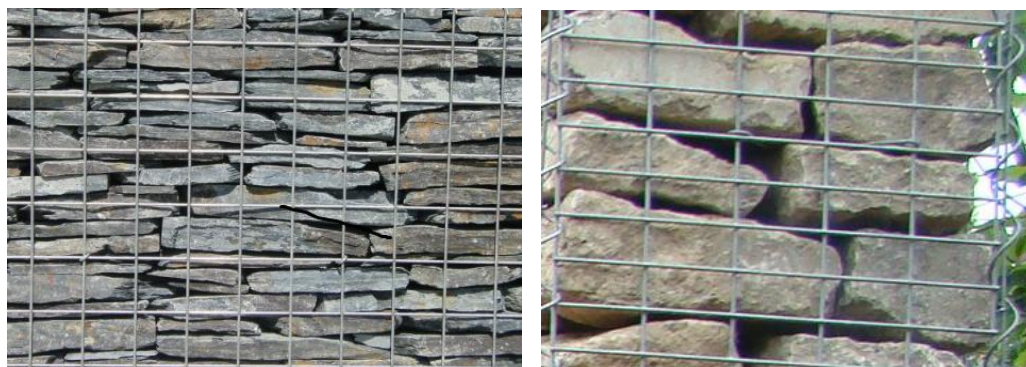
Obr. Nestabilná rovnanina nevhodná pre gabionové oporné múry
