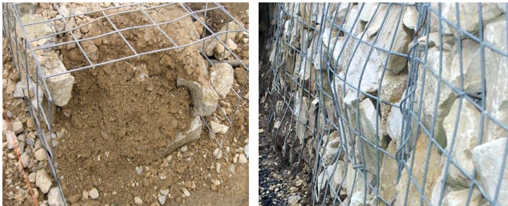
Obr.: Špatné plnenie a jeho dôsledky
