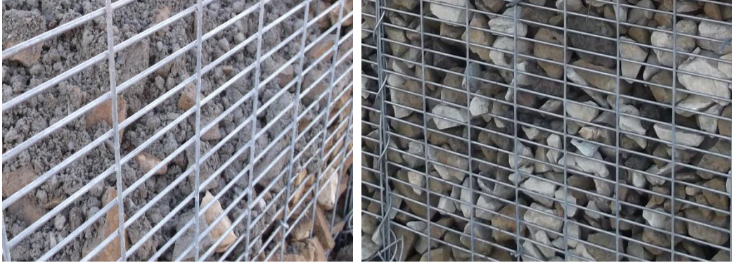
Obr.: Siete s okom 100/25 mm pre strojové plnenie s možnosťou použitia frakcie 0-63 mm ostrohranné i oblé kamene
