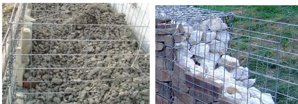
Obr.: Ekonomicky a esteticky optimálne plnenie pre oporné konštrukcie
