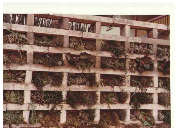
Obr. 2. Oporná stena kotvená do vystuženej zeminy, schéma (naľavo), stavba v Harmónii (napravo). Fig. 2. Retained wall anchored in reinforced soil, diagram (left), structure in Harmonia (right).
