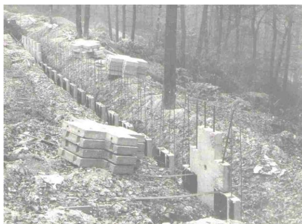
Obr. 4 Krížové prefabrikáty, forma (naľavo), na stavbe OMkLO v Košiciach (napravo). Fig. 4 Cross panels, form (on the left), OMkLO structure in Košice (right).
