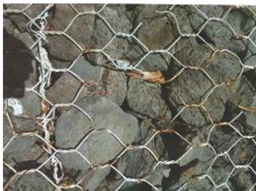
Obr.5 Prejav UV žiarenia v kombinácii s vplyvom mrazu
