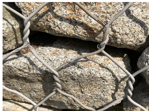
Obr.5 Prejav UV žiarenia v kombinácii s vplyvom mrazu
